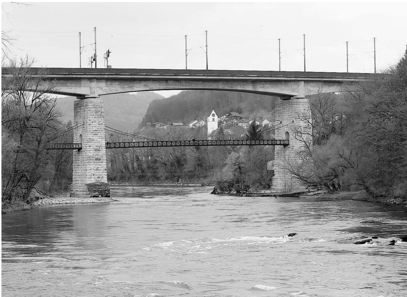
EISENBAHNBRÜCKE BRUGG-UMIKEN AM 4. APRIL. RAPHAEL HÜNERFAUTH
